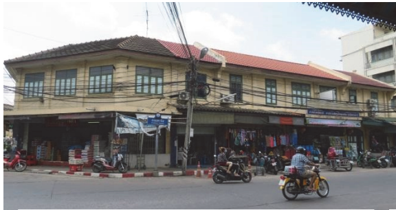
รูปที่ 7: อาคารพาณิชย์เก่าแก่บริเวณถนนพานิช
