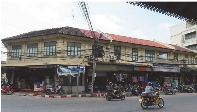
อาคารพาณิชย์เก่าแก่บริเวณถนนพานิช
