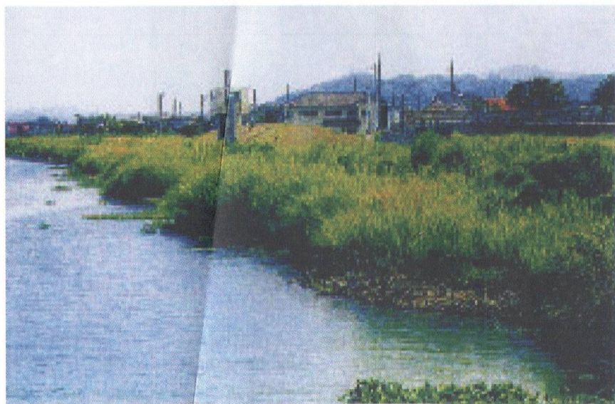
▲ 18 เดือนหลังการก่อสร้าง (กันยายน 1996)
