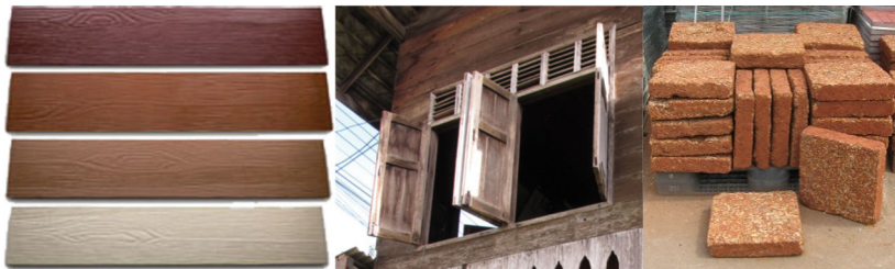
ไม้เทียมหรือไม้จริงสามารถนำมาใช้เป็นองค์ประกอบที่สำคัญสำหรับผนังร่วมกับการใช้ศิลาแลง
