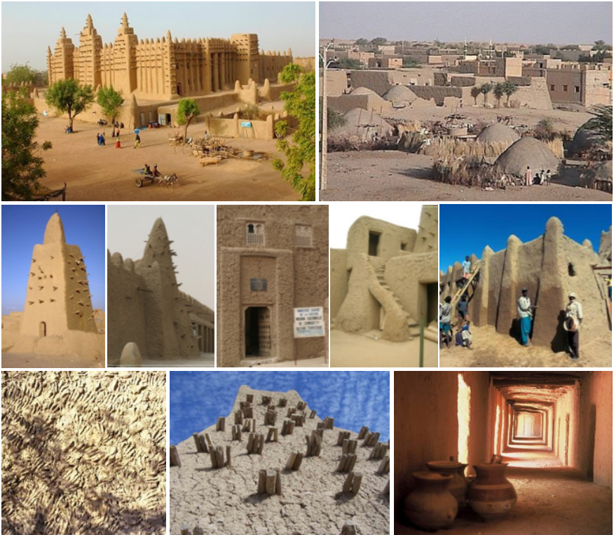
รูปที่ ๒๒ โครงสร้างอาคารและสิ่งปลูกสร้างต่างๆ ภายในเมืองทิมบักตูที่ ทำจากดิน ฉาบดินโคลนและมีเสาไม้เสียบไว้ภายในเพื่อรับน้ำหนัก ที่มา: กรมเอเชียใต้ ตะวันออกกลางและแอฟริกา กระทรวงการต่างประเทศ (๒๐๑๑ข)
