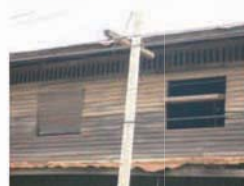
รูปแบบการเปิดหน้าต่างโค้ง เป็นแบบบานหมุน ๑๘๐ องศา
