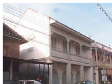
อาคารกาญจนวงศ์ ตึกแถวหลังคาจั่วตัดทางขวาง เดิมเป็นของตระกูลกาญจนวงศ์
