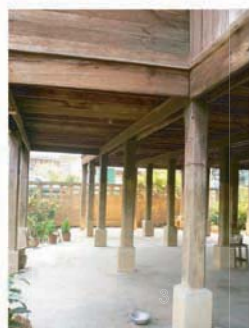
(ซ้าย)เรือนพื้นดินประยุกต์ บริเวณถนนบุญโยง (บน)การปรับปรุงในส่วนโครงสร้างเสาและฐานรากเรือน (ขวา)การปรับปรุงในส่วนของหลังคา มีการเปลี่ยนวัสดุแบบแต่รูปทรงเดิม
