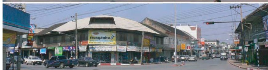
อาคารร้านค้าพาณิชย์ที่อยู่หัวมุมถนน นิยมทำเป็นหลายเหลี่ยมรับกับมุมเลี้ยวของแยกถนน ทั้งที่เป็นอาคารปูนและอาคารครึ่งไม้ครึ่งปูน ส่วนมากเป็นงานที่ได้รับอิทธิพลจากวัฒนธรรมต่างประเทศที่เข้ามากับรถไฟ
