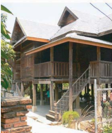
(ซ้าย)เรือนพื้นดินประยุกต์ บริเวณถนนบุญโยง (บน)การปรับปรุงในส่วนโครงสร้างเสาและฐานรากเรือน (ขวา)การปรับปรุงในส่วนของหลังคา มีการเปลี่ยนวัสดุแบบแต่รูปทรงเดิม
