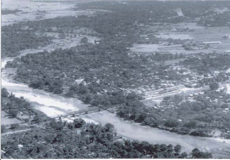
ภาพถ่ายทางอากาศบริเวณสะพานด้ ที่มา : หอจดหมายเหตุแห่งชาติ
