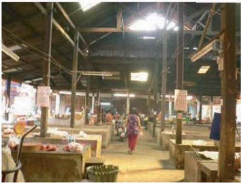
ที่ว่างภายในของอาคารตลาดโชคชัย ลักษณะโครงสร้างคล้ายกับตลาดเก่าจาว
