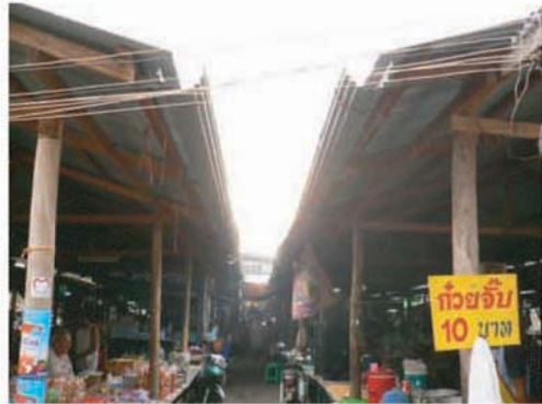
ช่องแสงที่เกิดจากระยะของหลังคา
