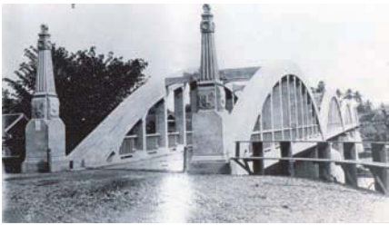
สะพานรัชฎาภิเศก โครงสร้างคอนกรีตเสริมเหล็ก สร้างเสร็จ พ.ศ.๒๔๖๐ ที่มา : หอจดหมายเหตุแห่งชาติ
