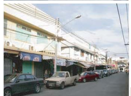
ส่วนอาคารตรงหัวกลางจะวางตัวยาวตามถนน
