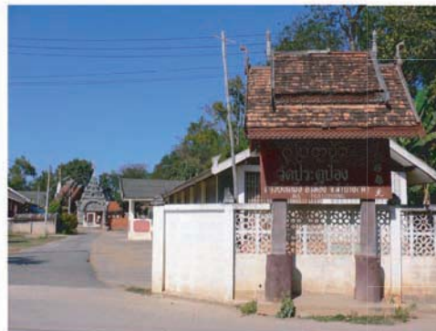
มุมมองประตูทางจากเข้าภายใน
