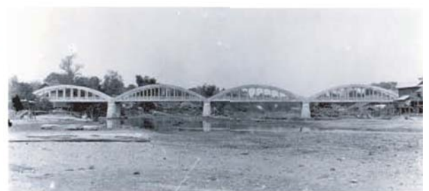
สะพานรัชฎาภิเศก ก่อนหน้านั้นมีการสร้างมาก่อนแล้ว เป็นสะพานโครงสร้างไม้ประกอบด้วยเหล็ก แต่ก็ไม่คงทนถาวรได้เกิดพังทลายลงในเวลาต่อมา จึงมีการสร้างขึ้นใหม่ แล้วเสร็จในปี พ.ศ.๒๕๖๐ ที่มา : หอจดหมายเหตุแห่งชาติ
