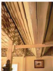
(ซ้าย) ที่ว่างภายในบ้านที่ มีการถ่ายเทอย่างลงตัว (กลาง) ประตูบานเฟี้ยม เชื่อมต่อส่วนโถงกับระเบียง (ขวา) รางน้ำ มองจากด้านใน
